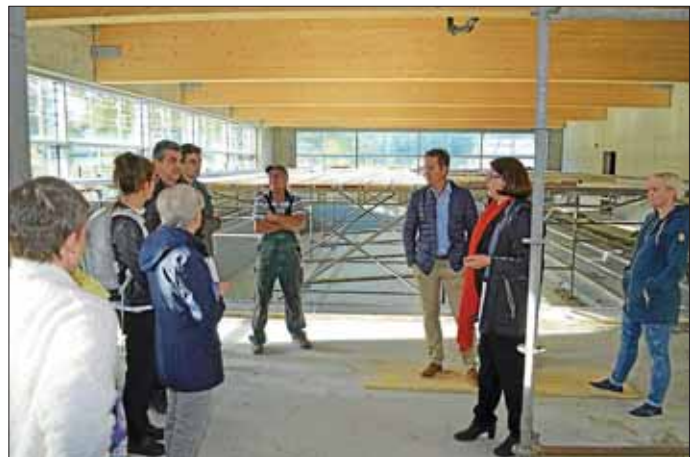
Mit Blick in das neue Lehrschwimmbecken
