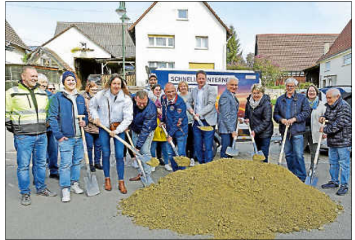
Spatenstich: schnelles Internet für Weilheim
