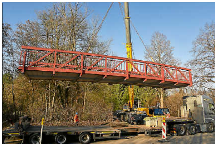
Auf 42 Meter war der Kranarm ausgefahren, möglich sind 60.
