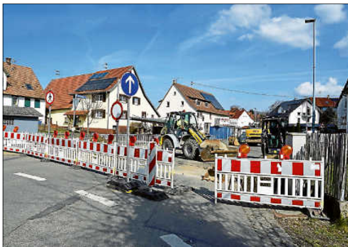
Vollsperrung der Zinkenstraße
