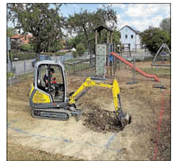
Aushub der Fundamentgrube.
