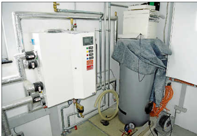
Der Technikraum mit Übergabestation (links) und Warmwasserspeicher.
